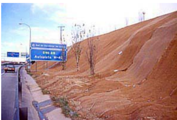
Figura 4. Revegetación de los taludes de la autovía M-40 de Madrid (España) en la que los plantones emergen a través de pinchazos realizados en una manta orgánica. Este recubrimiento puede adquirirse con la mezcla de semillas incorporada o bien utilizarse como soporte para hidrosiembras.
