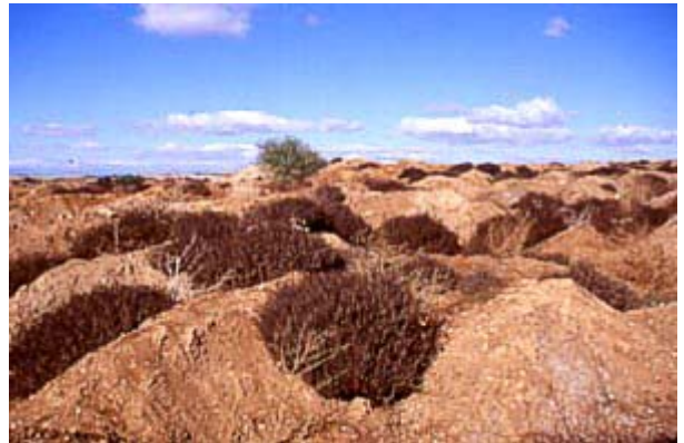
Figura 5. La recomendación es estructurar los acopios temporales de tierra vegetal en caballos paralelos, de geometría trapezoidal. Sin embargo, habitualmente sólo se respeta el que los acopios no superen los 2 m de altura para evitar la compactación de las capas inferiores.
